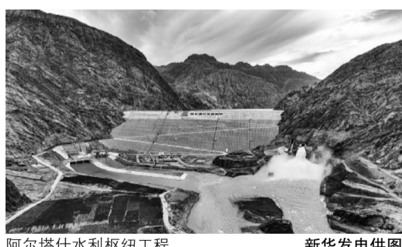
阿尔塔什水利枢纽工程。新华发电供图
